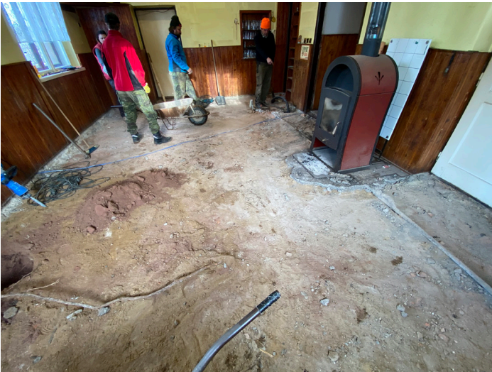
Výčep v době opravy
