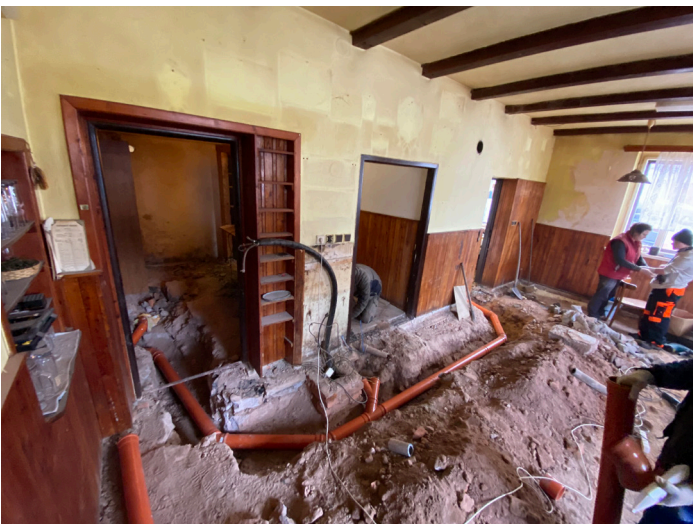
Výčep v době opravy
